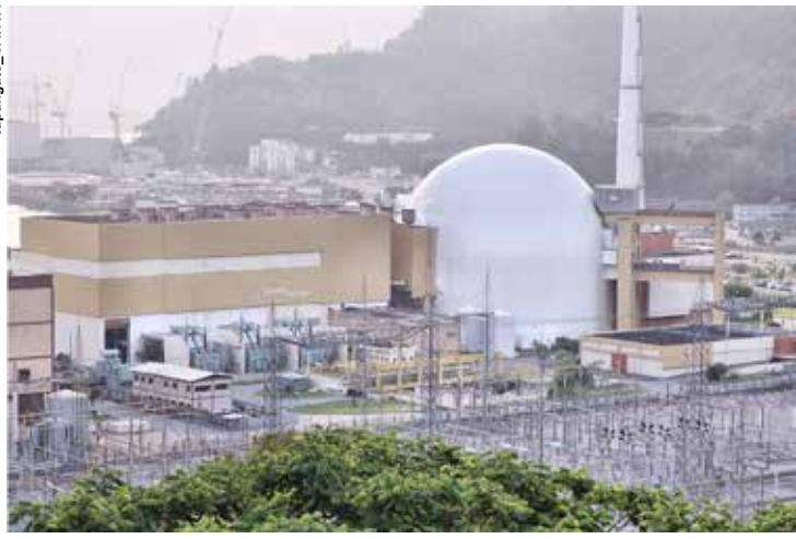
O texto prevê diversos atos e contratos para que a Eletronuclear conclua as obras da usina de Angra 3.
