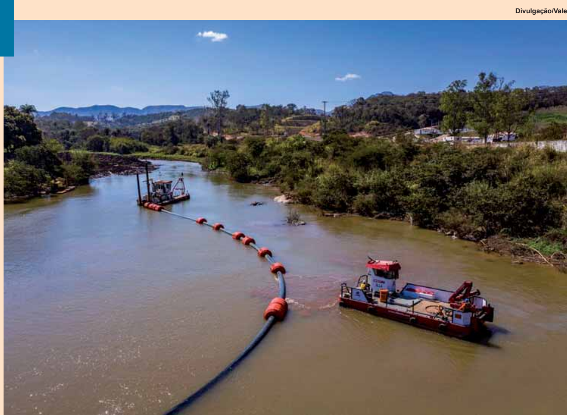
As obras contribuirão para uma redução significativa da turbidez da água do rio.
