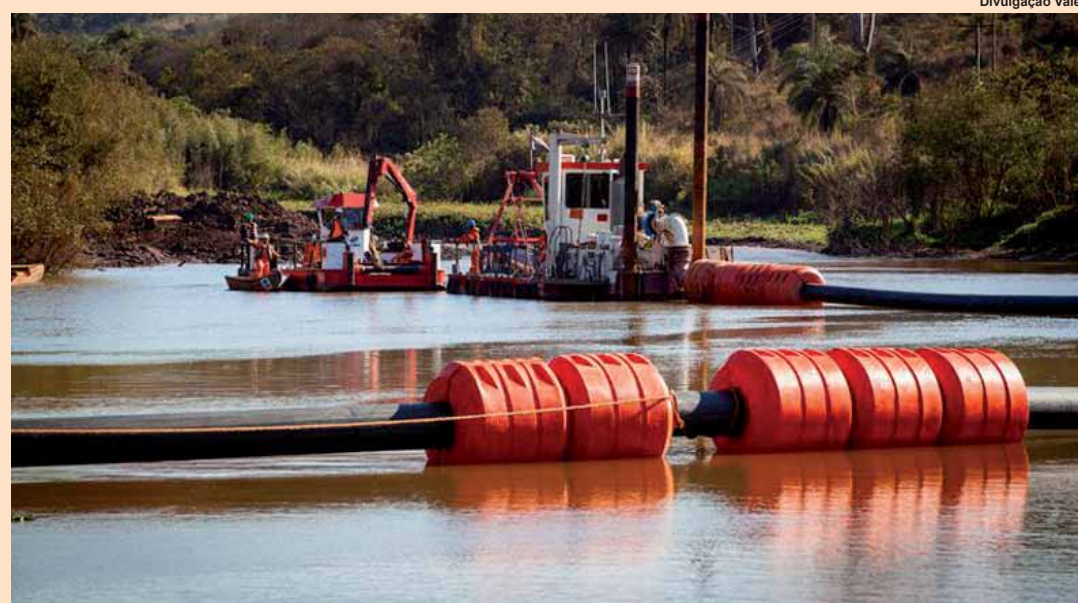
Foram instaladas estruturas de dragagem para retirar lama do Rio Paraopeba.
