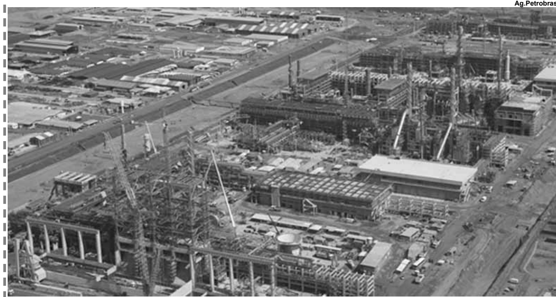
Obras do Complexo Petroquímico do Rio de Janeiro (Comperj).
