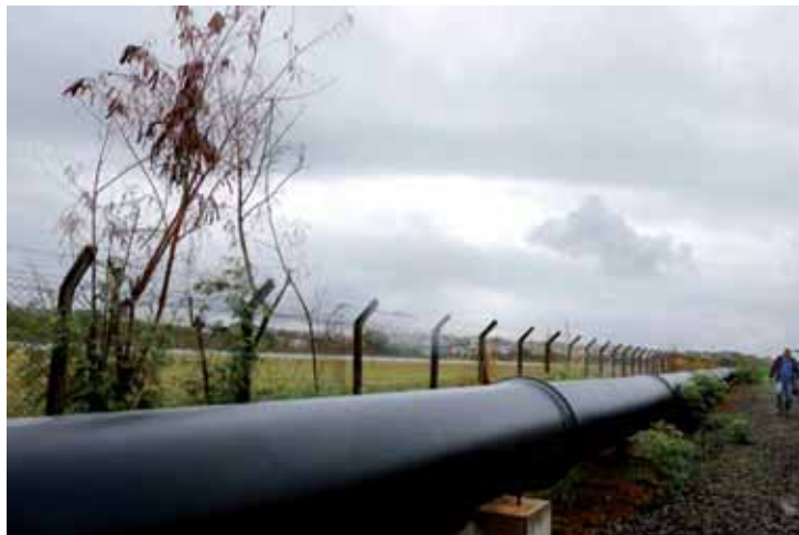
Dutos instalados ao longo do perímetro urbano de Governador Valadares.
