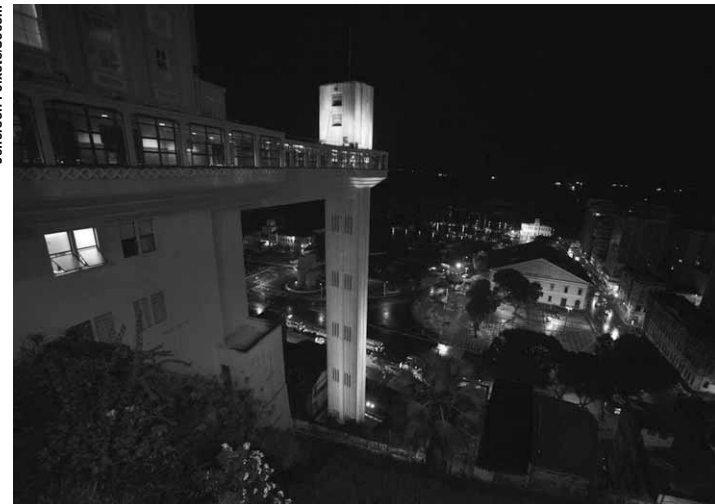
Elevador Lacerda, o primeiro elevador urbano do mundo, inaugurado em 1873, em Salvador.
