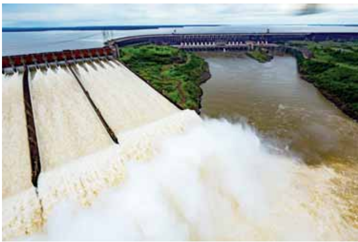
Com 20 unidades geradoras e 14 mil MW de potência instalada, a Itaipu Binacional é líder mundial na geração de energia limpa e renovável.
