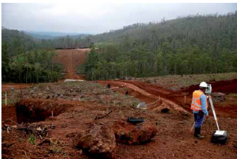
Canteiro de obras da Nova Bento Rodrigues.
