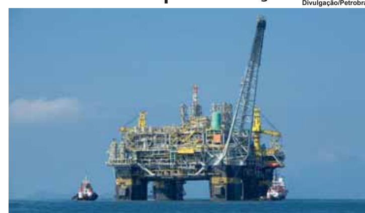
A plataforma tem capacidade para processar diariamente 150 mil barris de petróleo.
