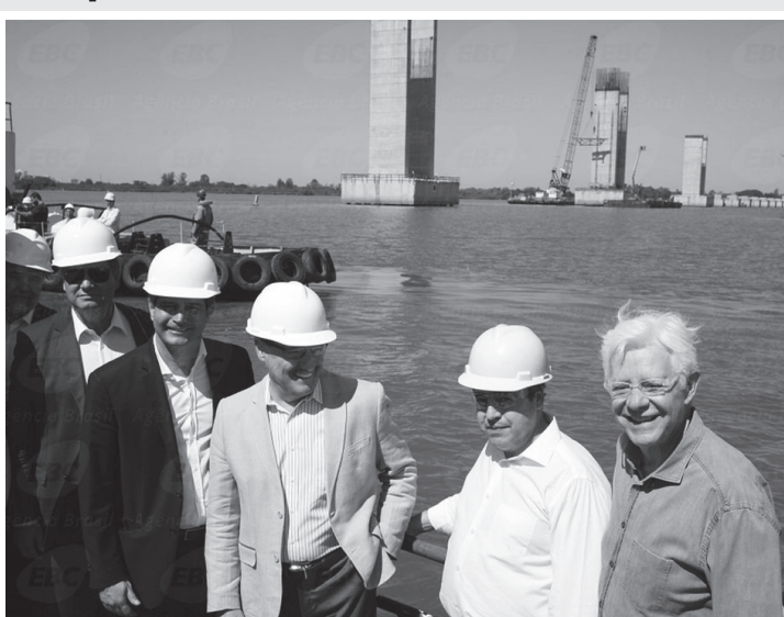
Ministros visitam as obras de construção da segunda ponte sobre o Rio Guaíba, em Porto Alegre.
