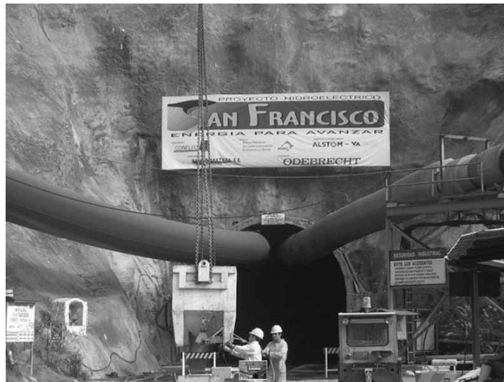
Uma das obras de responsabilidade da Odebrecht no Equador.
