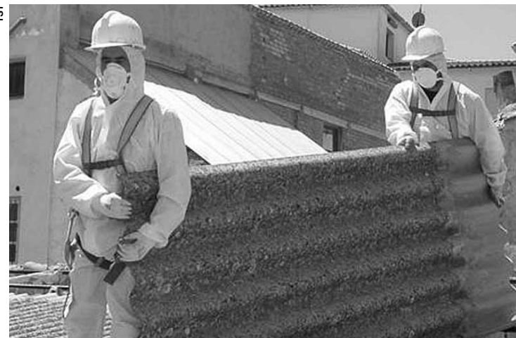
Trabalhadores manuseiam telha feita de amianto.
