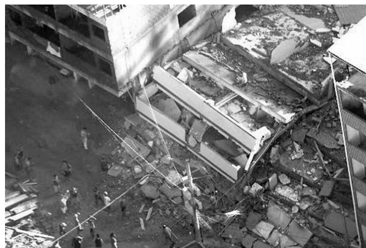
A prefeitura informou que o prédio que desabou já estava interditado desde o ano passado.
