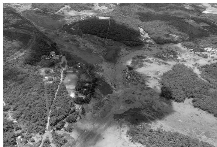
Área devastada pelo rompimento de barragem da Vale em Brumadinho: senadores se mobilizam para realização de CPI para apurar responsabilidades.
