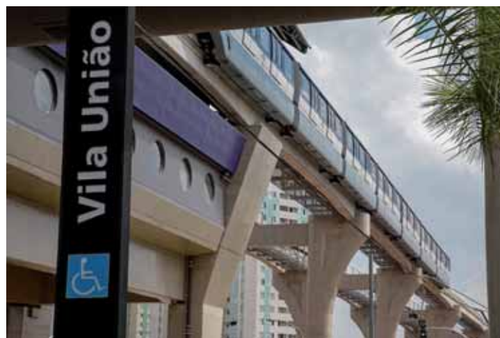
Estação Vila União, da Linha 15 Prata do Monotrilho.
