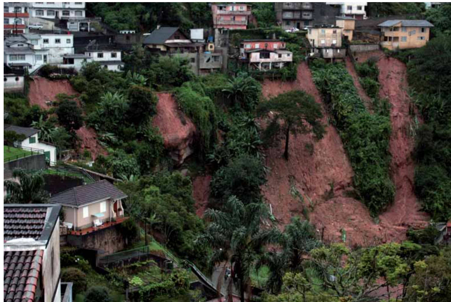
Teresópolis/RJ registrou grandes deslizamentos de terra.
