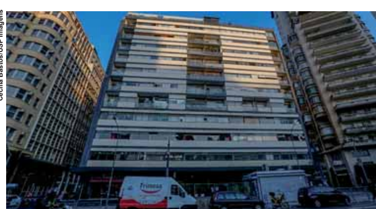
Edifício Esther: feito em concreto armado e alvenaria em 1938, foi o primeiro prédio de grande porte da cidade.
