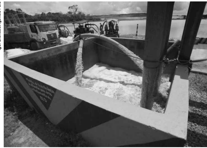
Secretaria de Meio Ambiente do Par monitora nveis das bacias do sistema de tratamento de rejeitos nas instalaes da mineradora Hydro AluNorte, em Barcarena.
