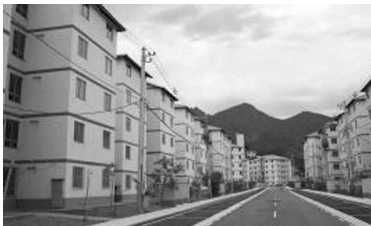
Conjunto residencial do Programa Avançar, em Jacarepaguá, que retomou obras inacabadas.
