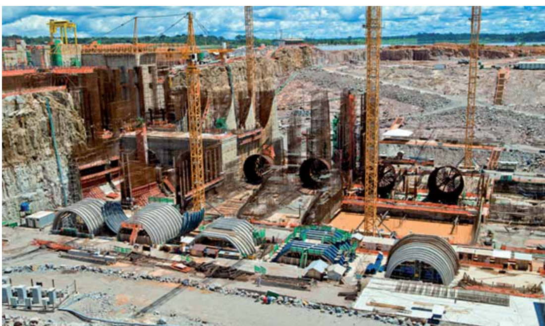
O setor de infraestrutura, altamente dependente de investimentos públicos, foi o que mais sofreu com a falta de recursos e a suspensão de investimentos importantes para o setor.
