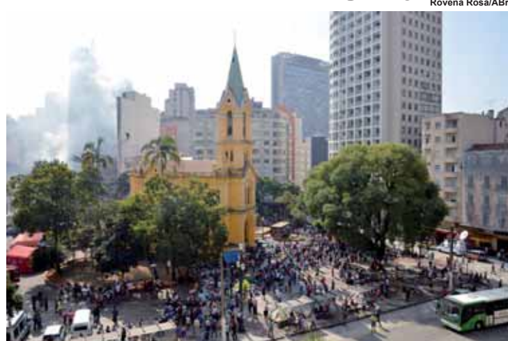
Desabrigados do prédio que desabou após incêndio na madrugada de terça-feira (1) acampam em frente a Igreja Nossa Senhora do Rosário dos Homens Pretos, no Largo do Paissandu.
