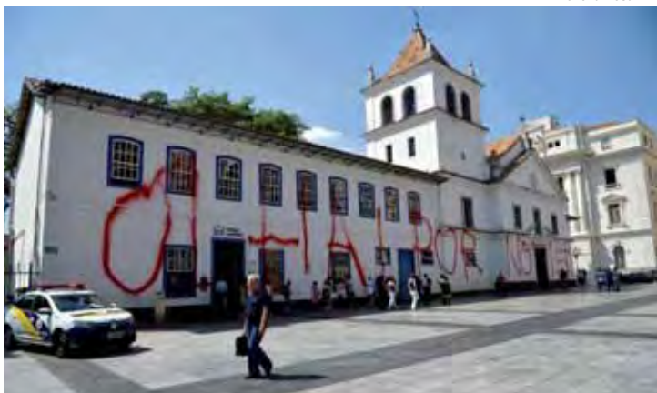
O prédio do Pateo do Collegio amanheceu com a sua fachada pichada.
