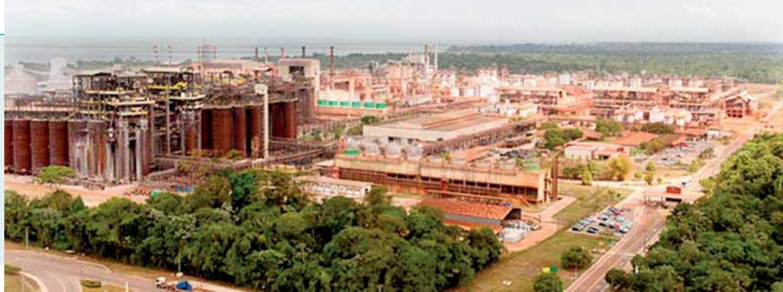
A mineradora de Barcarena, no Pará, informou que antes de ser liberada no rio de forma controlada, a água acumulada é tratada segundo critérios estabelecidos pelo Conselho Nacional de Meio Ambiente (Conama).
