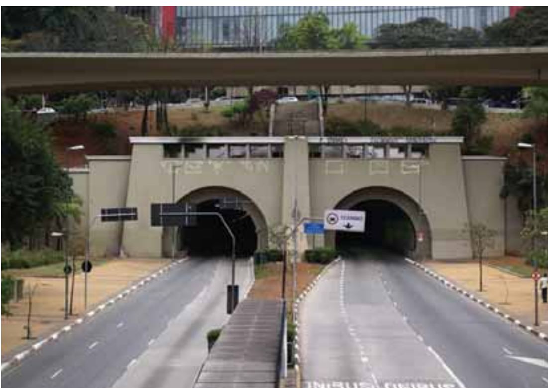
Na entrada do túnel há uma placa ostentando dois nomes: Túnel Nove de Julho - Dr. Daher Elias Cutait.
