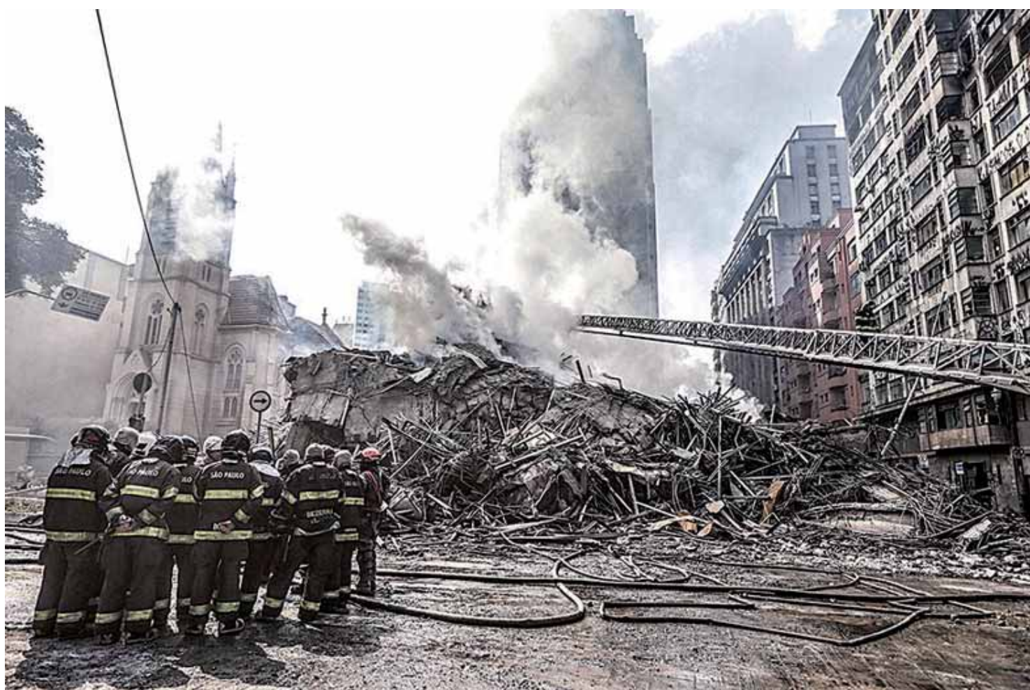
Incêndio provocado por curto-circuito transforma edifício Wilton em ruínas e mata ocupantes
