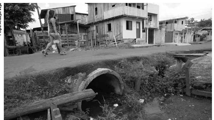
Obras e serviços no sistema de abastecimento e água e esgotamento sanitário.
